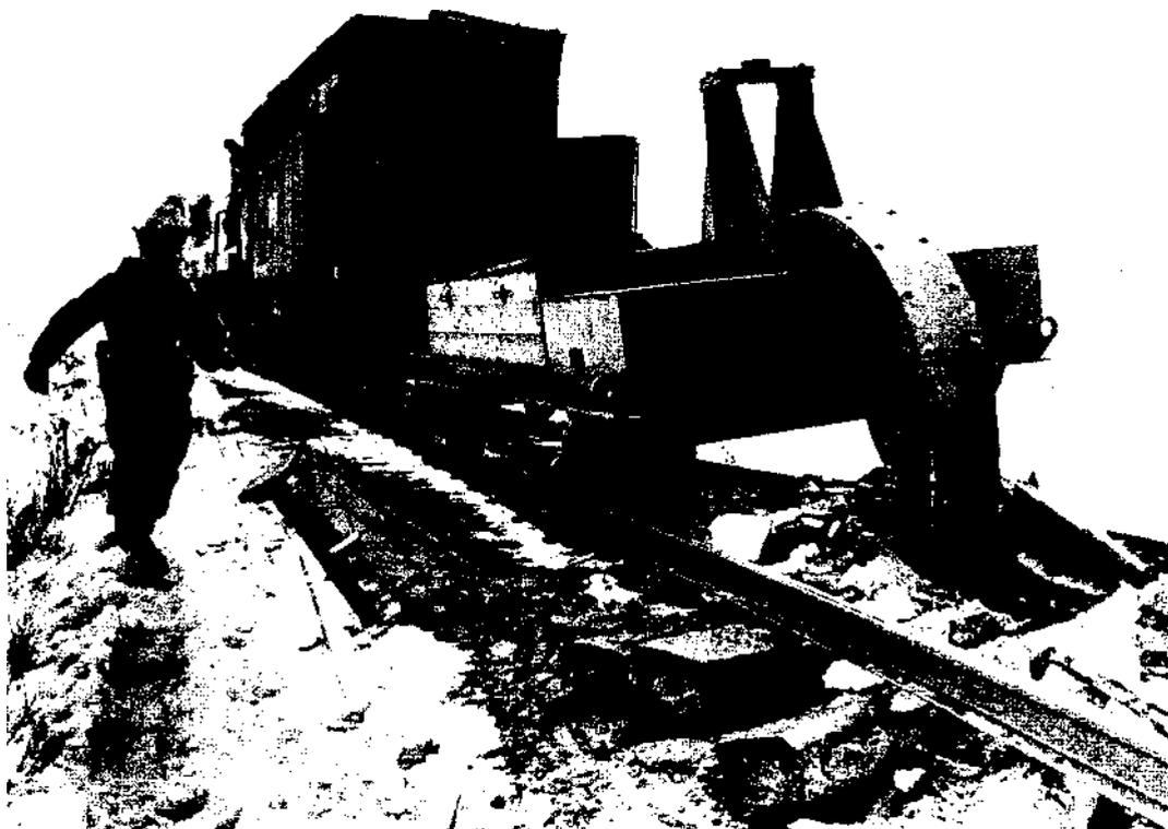
221 Немецкий «шпалолом» для разрушения железнодорожных путей, 1943/44 гг.
